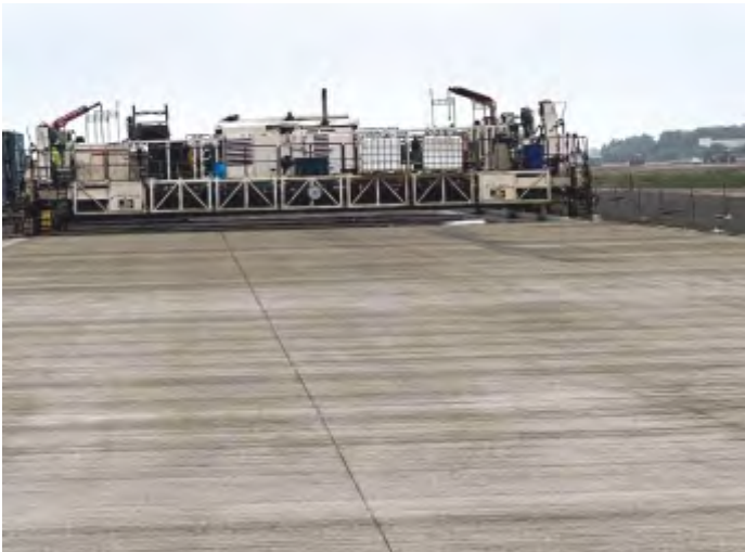
CİZRE-OYALI (İPEKYOLU) CONCRETE ROAD-TÜRKİYE
