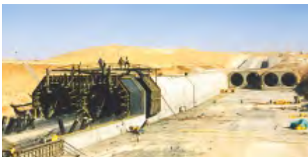
MARDİN-CEYLANPINARI IRRIGATION MAIN CANAL ŞANLIURFA-TÜRKİYE
