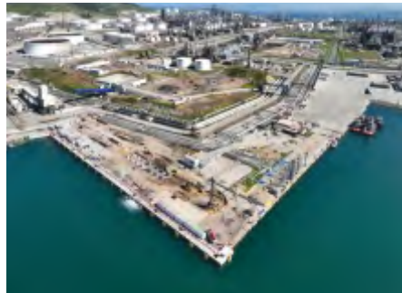
PETKİM JETTY MODERNIZATION, ALİAĞA, İZMİR-TÜRKİYE
