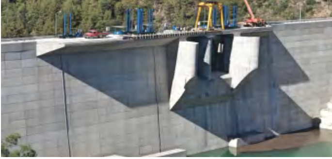
KASIMLAR DAM AND HEPP (100 MW), ISPARTA-TÜRKİYE
