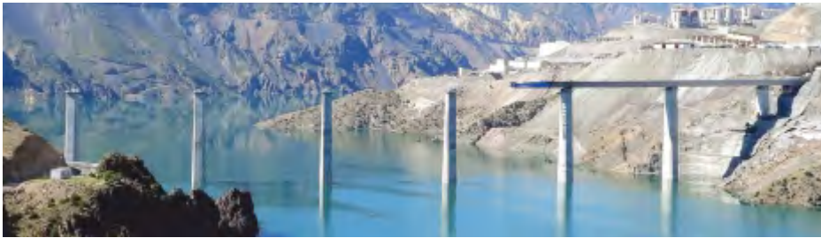
YUSUFELİ MERKEZ VIADUCT, ARTVİN-TÜRKİYE
