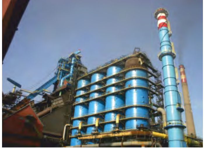
İSDEMİR BLAST FURNACE NO:3 MODERNIZATION, İSKENDERUN-TÜRKİYE
