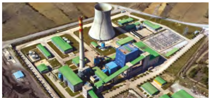
POLAT-1 THERMAL POWER PLANT, KÜTAHYA-TÜRKİYE
