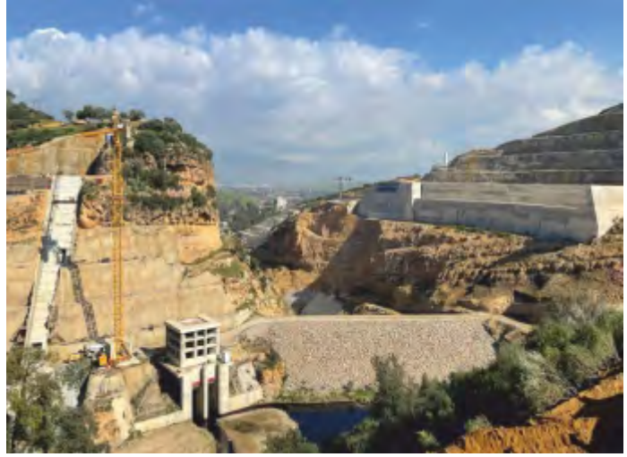
SOUK TLETA DAM, TIZI OUZOU-ALGERIA
