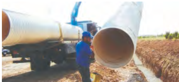
ARABAN SEWER SYSTEM, GAZİANTEP-TÜRKİYE
