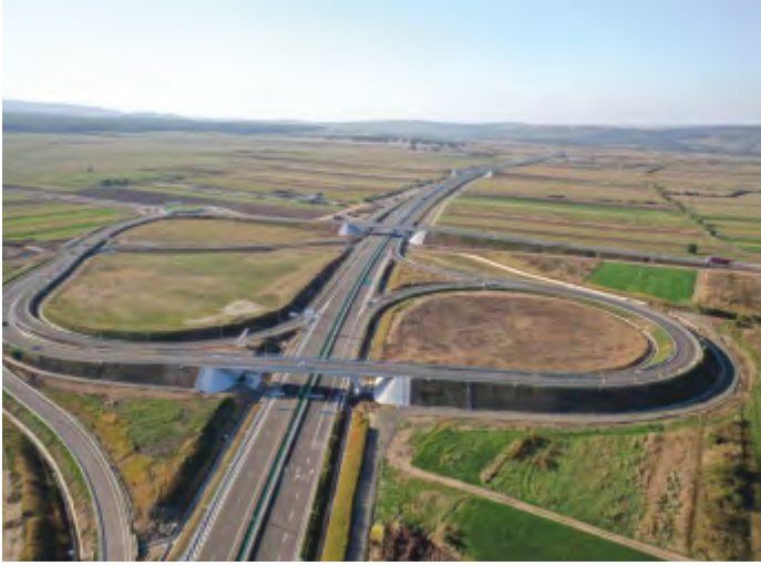
NUSFALAU-SUPLACU DE BARCAU HIGHWAY-ROMANIA
