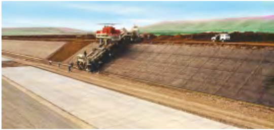
MARDİN-CEYLANPINARI IRRIGATION MAIN CANAL, ŞANLIURFA-TÜRKİYE
