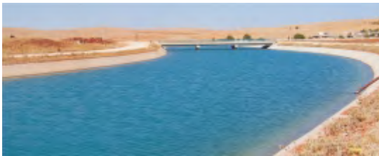
MARDİN-CEYLANPINARI IRRIGATION MAIN CANAL, ŞANLIURFA-TÜRKİYE
