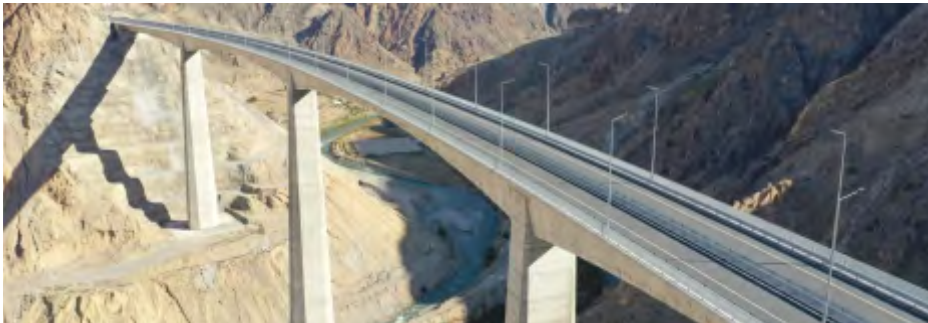
ŞİLENKAR VIADUCT, ARTVİN-TÜRKİYE
